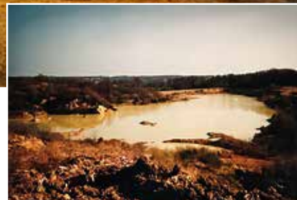
Réalisation du plan d'eau novembre 1993
